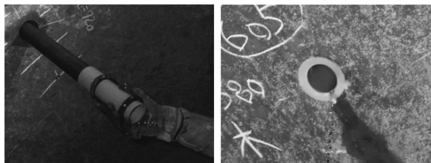
写真-8 水路トンネル頂部の施工状況
