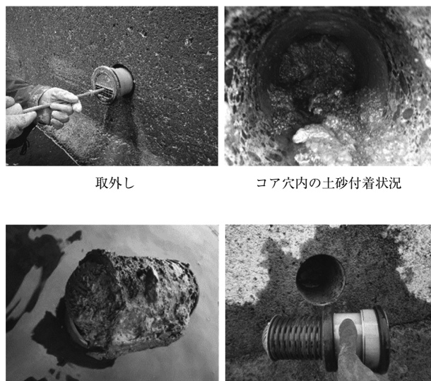
写真-5 洗浄・再設置状況
