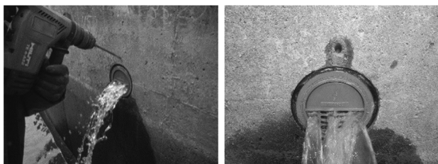
充填孔削孔
